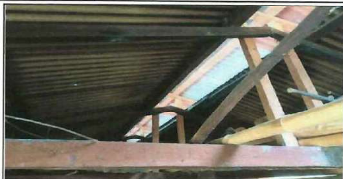
Foto 2: Se observa el deterioro de las costaneras de la cocina.
